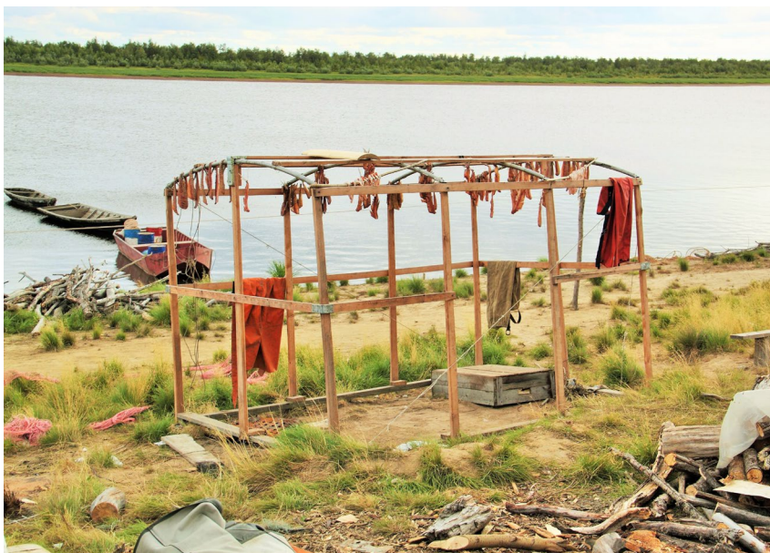
Рис. 2. Каркас шалаша из тонких струганных досок. Рыболовное угодье Надо-Марра (фото Ю.Н. Квашина, август 2013 г.).
