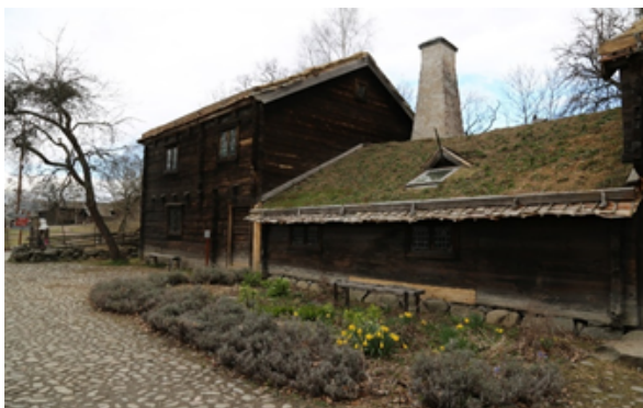
Рис. 2. Традиционная для крестьянских построек дерново-травяная крыша. Скансен. 2012 г. Фото Э. Ф. Рязановой
