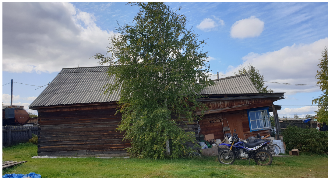
Рис. 6. Зброшеный из-за повышения температуры ММП под фундаментом дом в с. Юнкюр, сентябрь 2023 г. Фото автора
