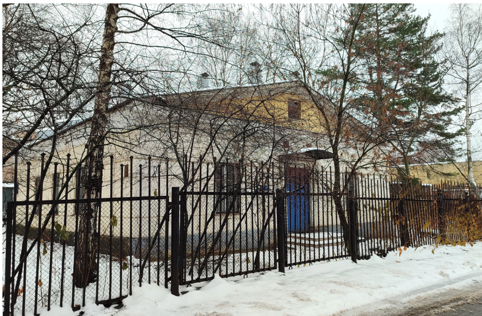
Рис. 1. «Желтый домик», в котором размещалась кинолаборатория кафедры УиНФиК (до 1986 г.), а позднее (до 2013 г.) — видеокомпьютерная лаборатория. Фото Е. Александрова
