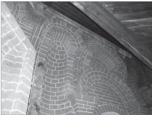
Храм Покрова на Рву. Карниз юго-восточного придела — под кровлей галереи
