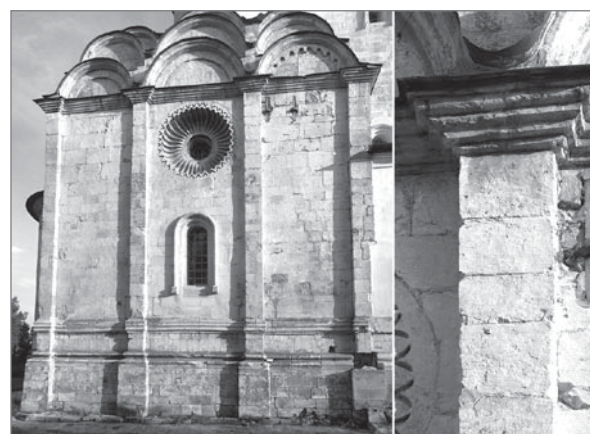
Никольский собор Антониева Краснохолмского монастыря (а) и придел Феодосия Великого храма Спаса Преображения в Острове (б) Сравнение ширины лопаток и профилей карнизов
